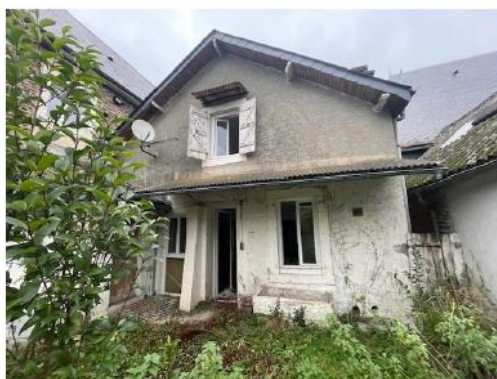
Façade Sud Ouest- côté jardin
