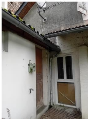
Façade Sud Ouest et façade Sud Est
