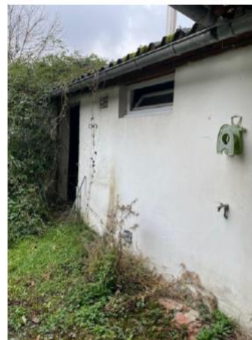
Façade Sud Est - local technique
