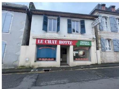
Façade Nord Est - côté rue
